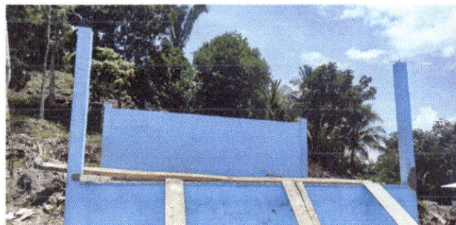
Foto 5: Escenario; en proceso de instalación del techo
