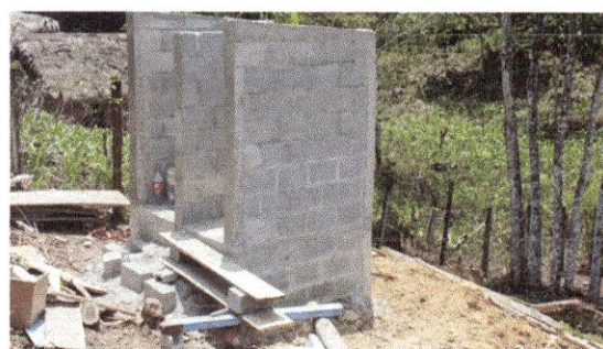
Foto 6: Letrina; en proceso de instalación
