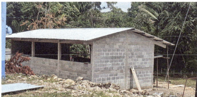
Foto 1: Techo; Cambio del techo terminado
